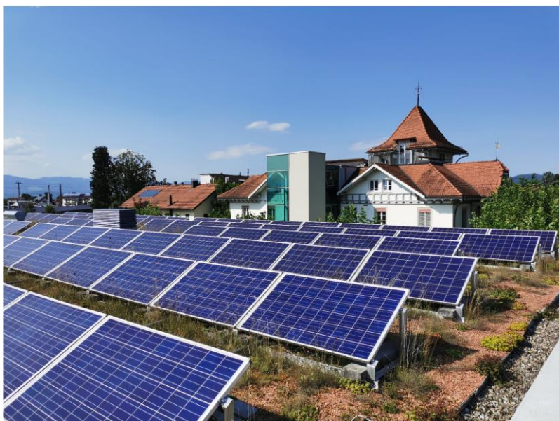
Abbildung 20: Biodiversitätsdach mit Photovoltaik in der e5-Gemeinde Rankweil.
