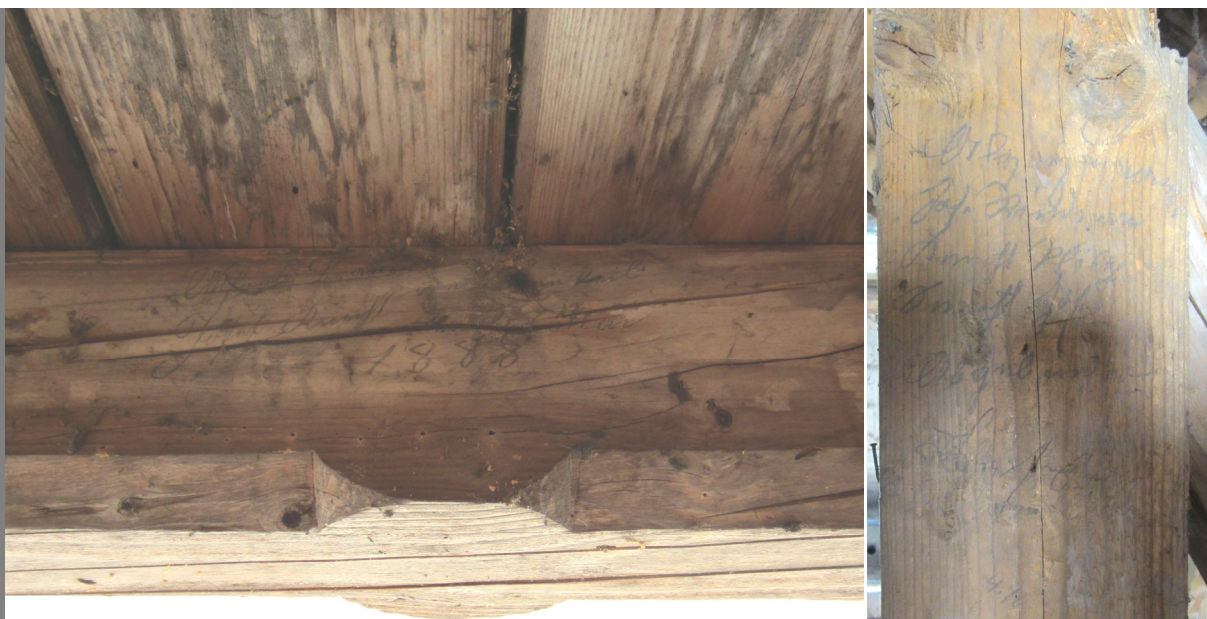
li. Traufbalken des westlichen Krüppel/Schopfwalmes, Untersicht mit dem Vermerk: Alfons Braner/Josef Knecht zu Rankweil im Mai 1888. re. Stuhlsäule mit Abbundhinweis: Alvons Braner/Jos. Riedman/Knecht Philip/Knecht Jos./Abgebunden
