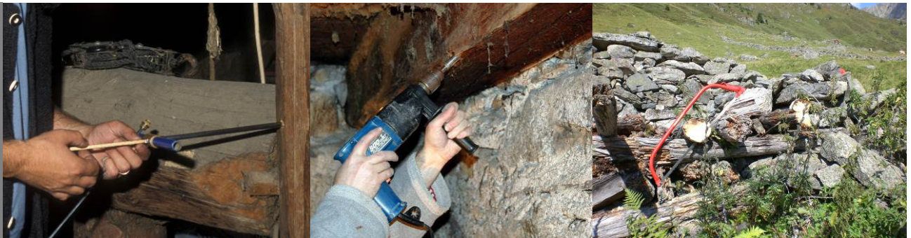
Schlüssel zum Bauarchiv – Probenbergung (Hohl-/Fräsbohrer, Bügelsäge)
