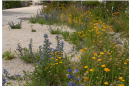
Stellplatz mit Blumen-Schotterrasen-Einsaat auf wassergebundener Wegdecke. Ein Kompromiss zwischen Natur und Technik. (Foto: Reinhard Witt)
