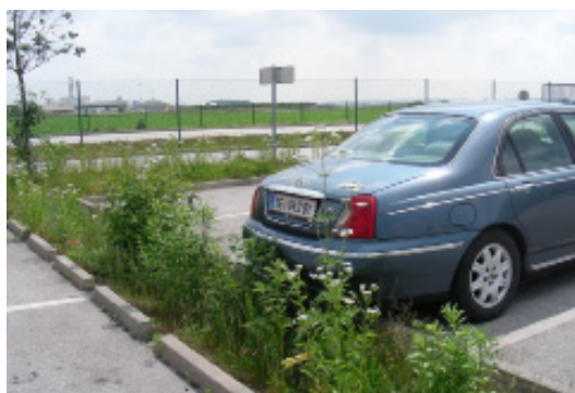
Naturnahe Regenwasserversickerung am Parkplatz. (Foto: Markus Kumpfmüller)
