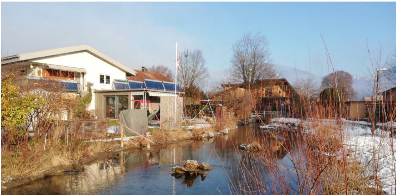
revitalisierter Mühlbach-Abschnitt in Rankweil
