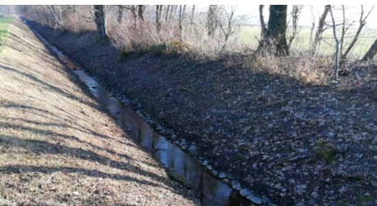
geradliniger Verlauf des Luttengrabens
