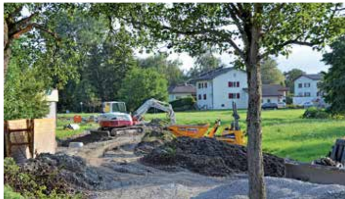
Erschließungsarbeiten am Brunnenbach 2019. | Foto: Benzer
