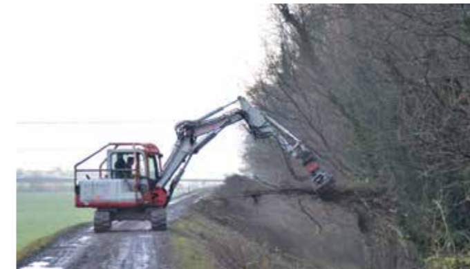
Links: Rodungsarbeiten am Rheindamm. Rechts: Der Instandhaltungsweg entsteht landseitig am Fuße des Rheindammes. | Fotos: Benzer
