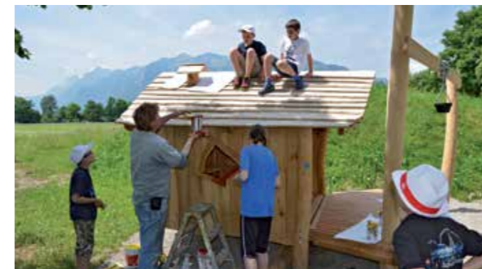
Dacharbeiten am Spielplatz Riedspitz...
