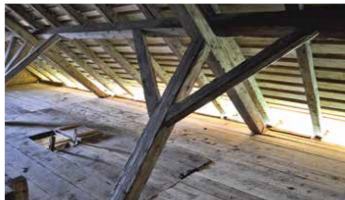
Unteres Hinterjoch: Den Walsern zugeschriebene typische Dachkonstruktion.
