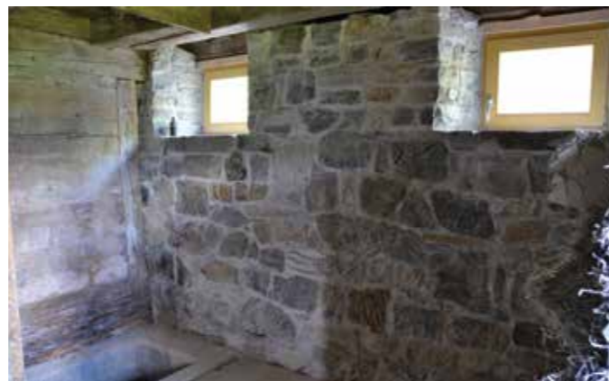
Unteres Hinterjoch: Holzstrick trifft auf die original wieder errichtete Steinmauer.
